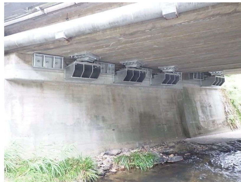
落橋防止装置・水平力分担構造
