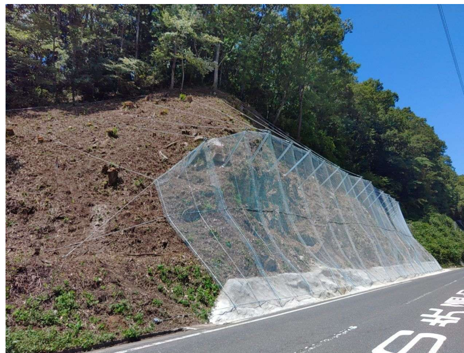
R7施工 国道184号（下来島工区）
