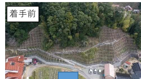
R7施工 急傾斜地崩壊対策施設（狩山地区）
