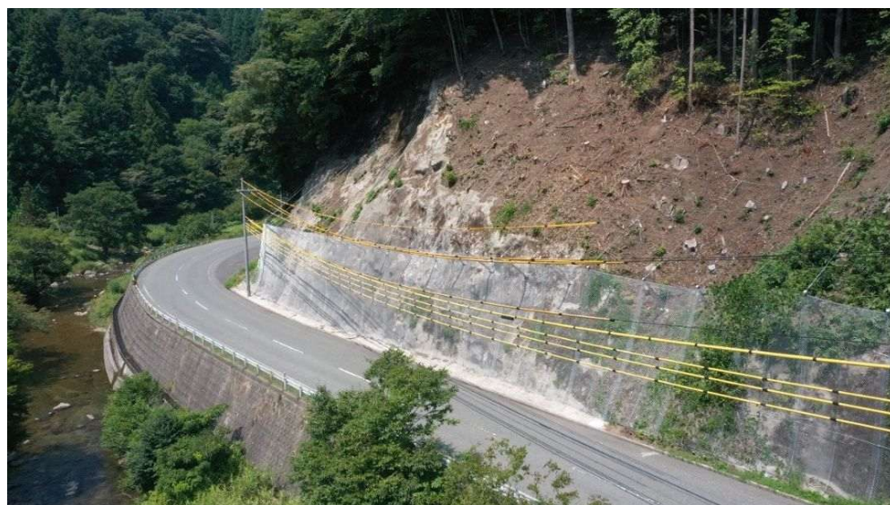
R7施工 掛合上阿井線（掛合工区）
