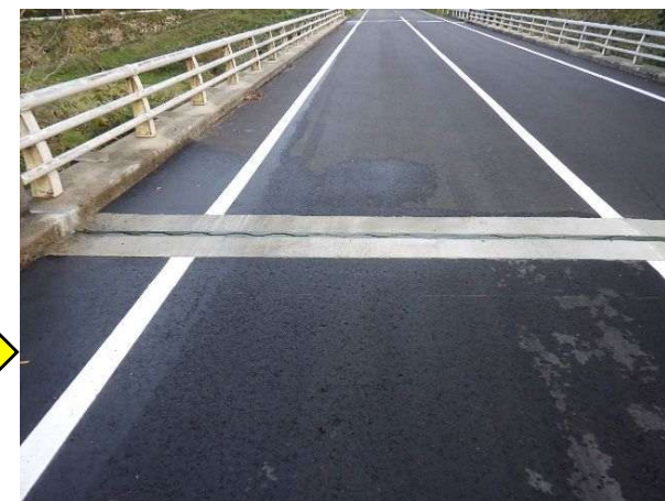
R7施工 吉田新橋 伸縮継手取替
