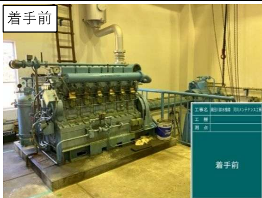
R6施工 奥田川排水機場 原動機更新
