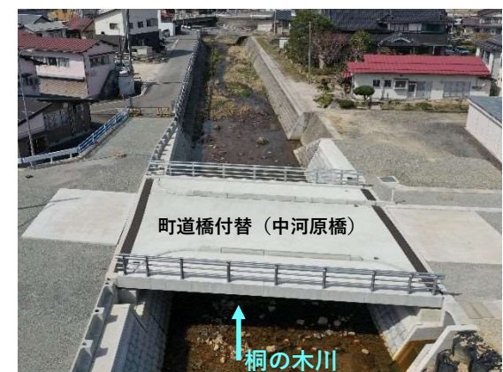
桐の木川 改修状況（奥出雲町横田地内）
