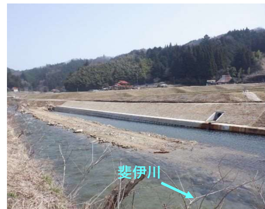
斐伊川 改修状況（奥出雲町竹崎地内）
