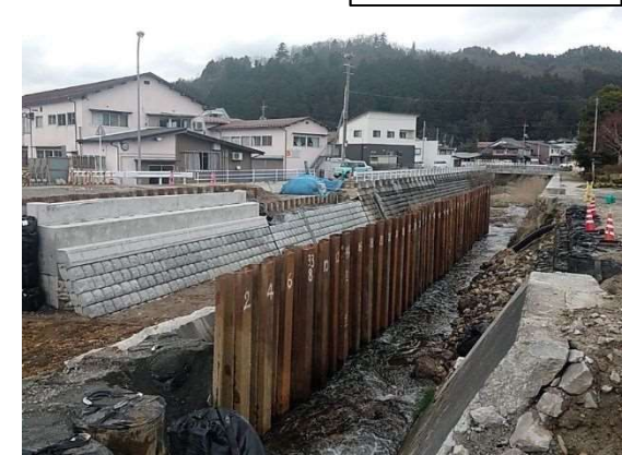
桐の木川 改修状況
