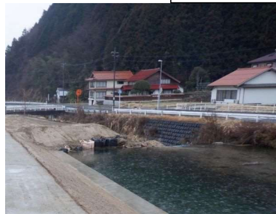
斐伊川 改修状況
