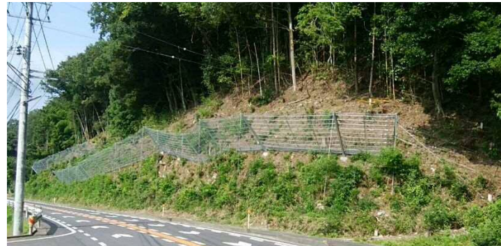
R4完了 出雲三刀屋線（給下工区）
