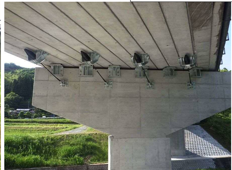
落橋防止装置・水平力分担構造
