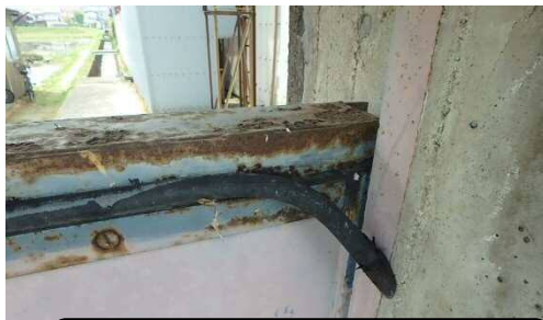
大木原樋門の水密ゴムの劣化 樋門作動時に漏水の可能性
