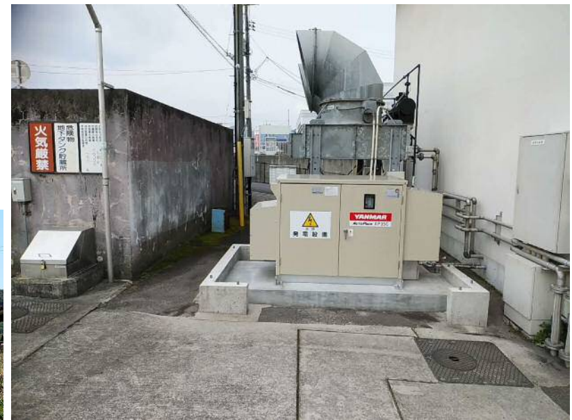
非常用発電設備 R3完成(内原川排水機場)
