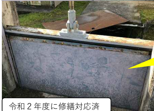
大木原樋門の水密ゴムの劣化 樋門作動時に漏水の可能性
