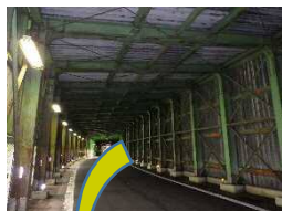
R3施工 角井防雪坑
