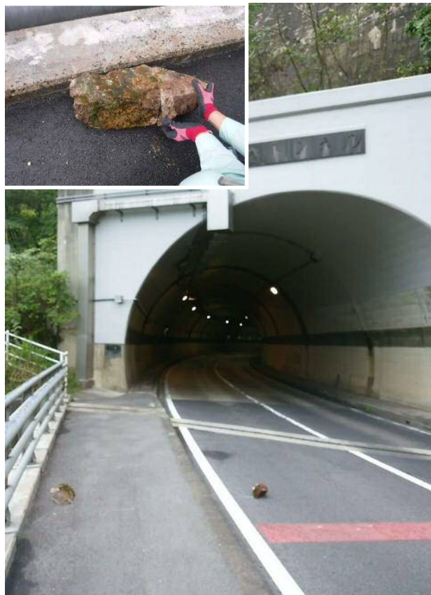
対策前の落石 H28.8.30 国道314号（西日登工区）
