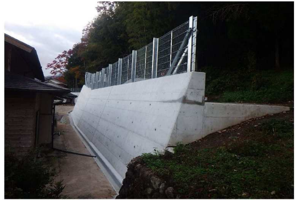
待ち受け擁壁完成写真(終点側)
