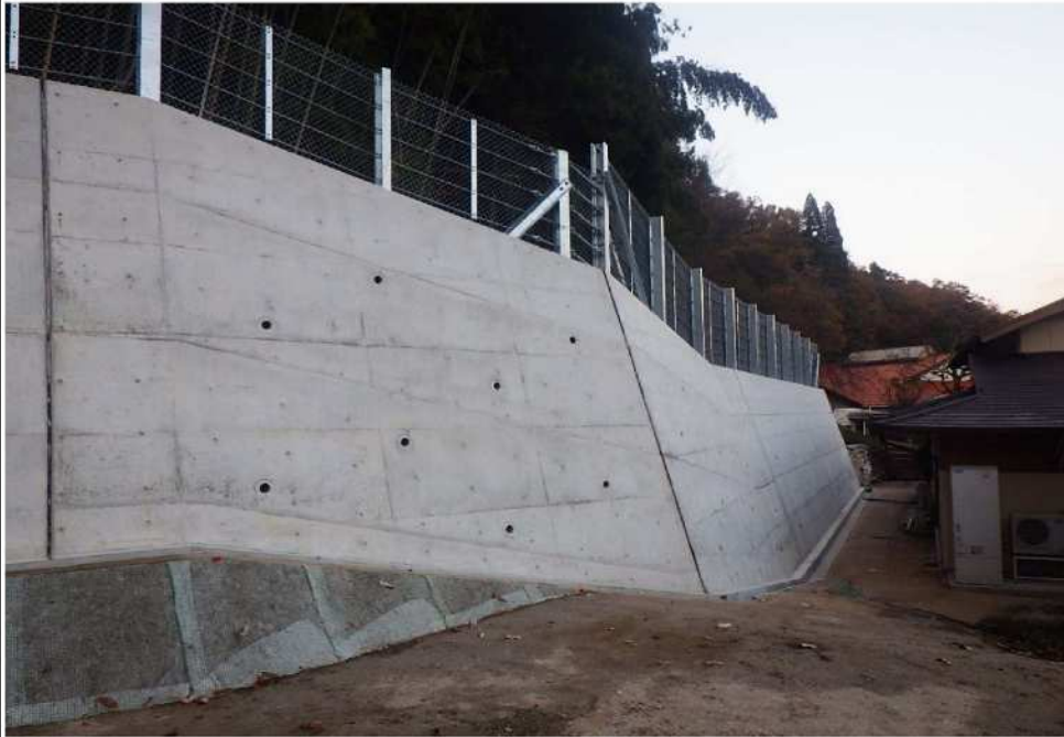
待ち受け擁壁完成写真(起点側)
