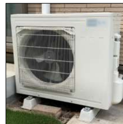
エアコンディショナーの室外ユニット 及び電気温水機器のヒートポンプ
