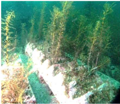
ハード対策（藻場礁設置）
