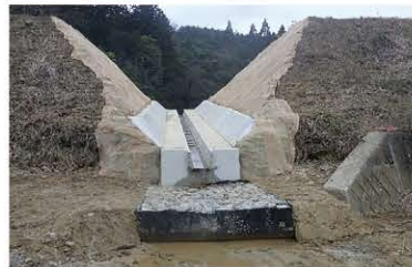
〈廃止工事（堤体の開削）（松江市）〉
