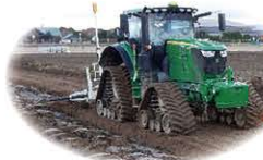
【反転均平工法を採用した整備】
