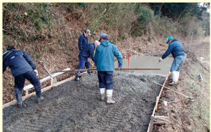
農道をコンクリートで舗装しています。
