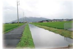
【断面不足の排水路】
