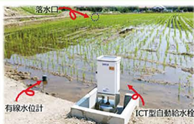
ICT型自動給水栓の設置状況
