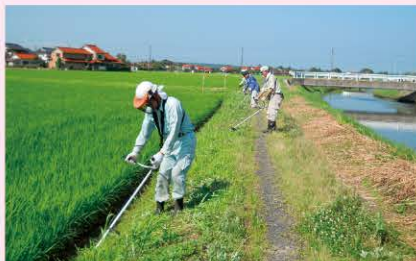
農道法面の草刈を行っています。
