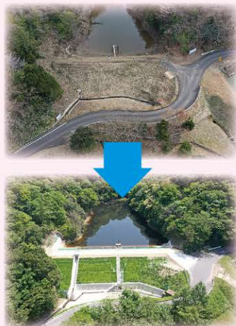
〈ため池の改修（出雲市）〉
