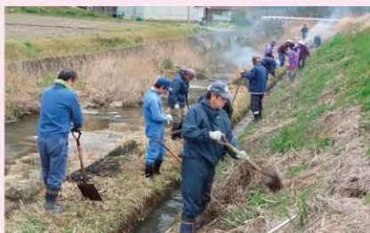
用水路に溜まった泥上げを行っています。
