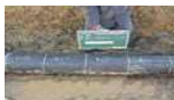
【幹線パイプライン調査状況】
