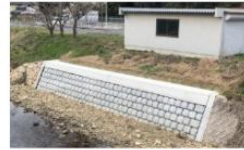
災害復旧工事
