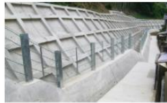
急傾斜地工事
