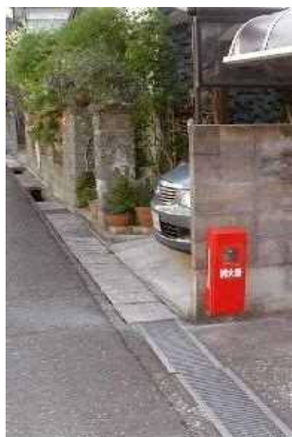
町内15カ所に屋外消火器設置
