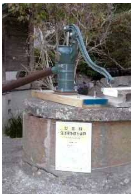
災害時協力井戸の設置 (町内4カ所)
