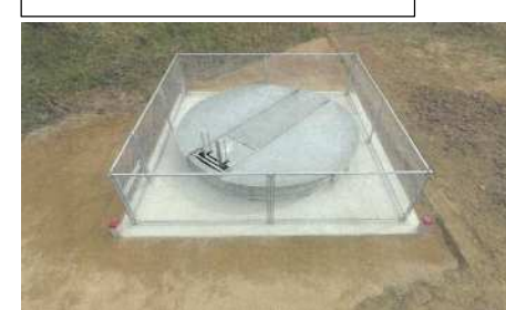
地下水排除工（集水井）
