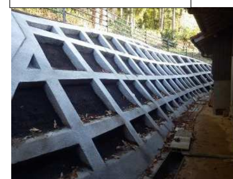
斜面改良工（法枠工）
