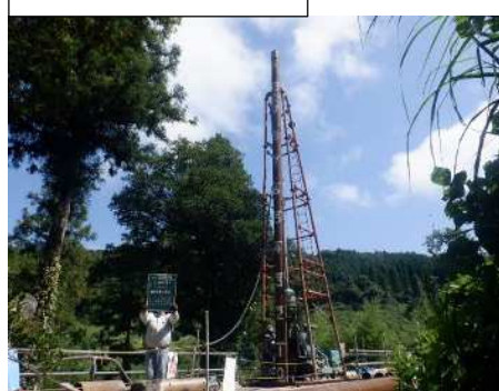
抑止工（杭工）
