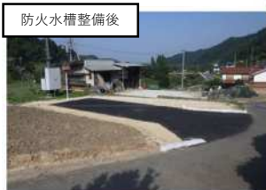
防火水槽整備後
