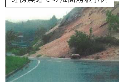
近傍農道での法面崩壊事例
