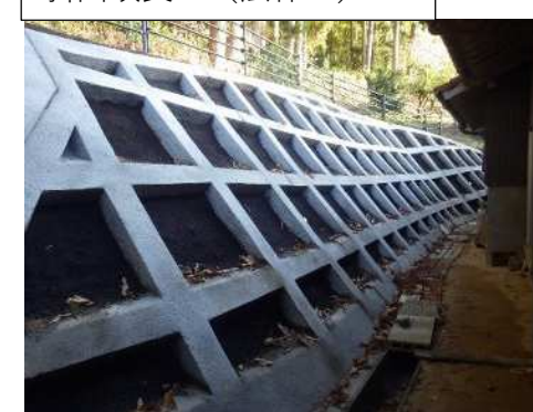
斜面改良工（法枠工）
