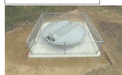
地下水排除工（集水井）
