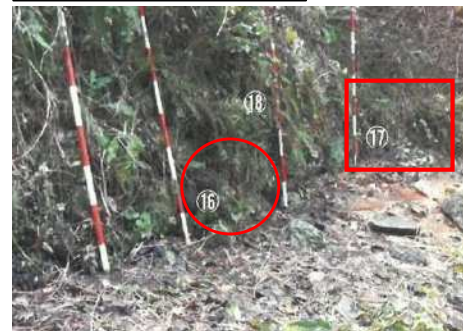
堤体下流側の漏水状況
