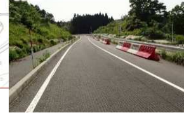
写真③ 供用済状況
