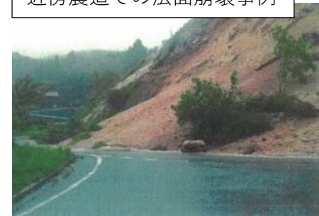
近傍農道での法面崩壊事例
