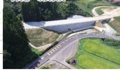
写真② 改良状況
