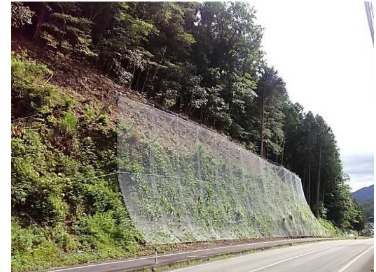
落石防護網設置 国道191号 美都町丸茂地内
