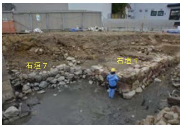
宍道湖護岸の石垣（北西から）
