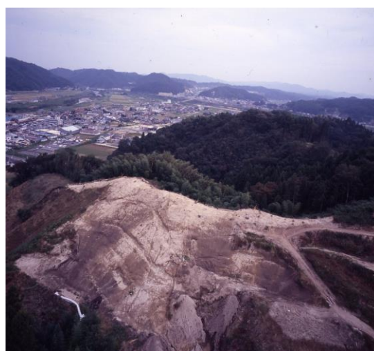
調査当時の空中写真。画面下方が熊谷遺跡。遺跡の北には斐伊川と三刀屋川の合流点を見下ろします
