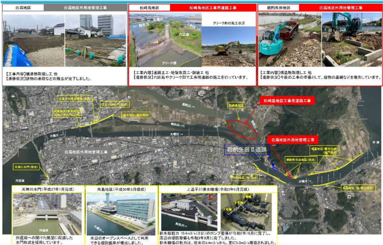
【図7】 大橋川改修工事状況
