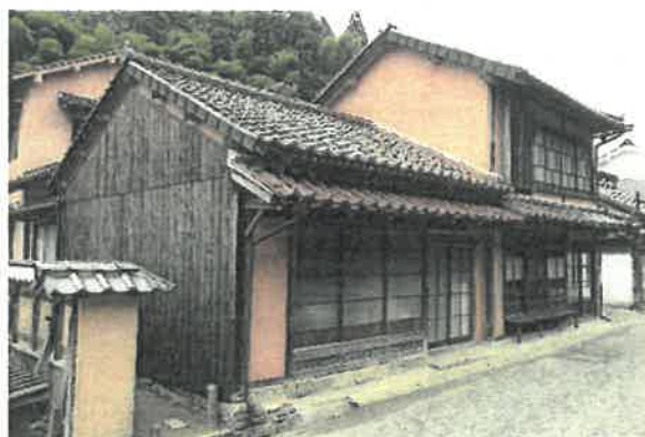
(島田家母屋修理)
