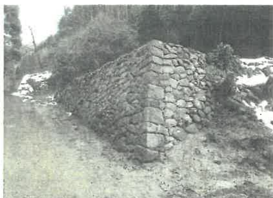
(清水谷精練所前石垣保存修理)
