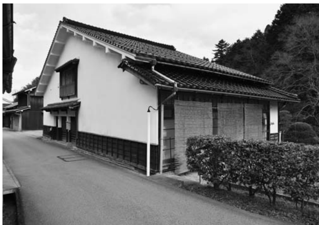
写真1 青山家正面外観
