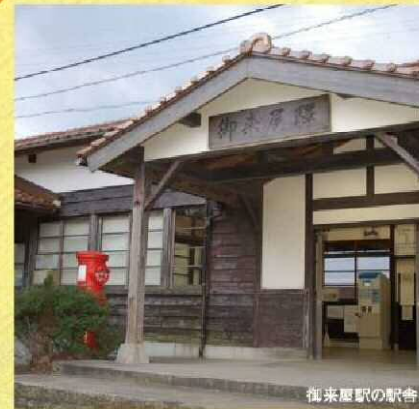
御来屋駅の駅舎
