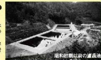
昭和初期以前の濾過池
