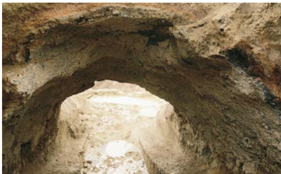
久本奥窯跡 （江津市嘉久志町） 江津道路建設に伴い調査された。奈良時代の瓦やしび（寺の屋根の両側にある飾り）須恵器を焼いており、近くでは作業場も見つかった。「石州瓦の起源ここにあり」である。
