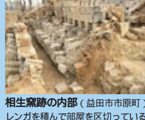
相生窯跡の内部 （益田市市原町） レンガを積んで部屋を区切っている。レンガの間に開けられたすき間を炎が通っていく。
