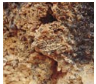
割目を粘土で補修。指の跡も見える。
