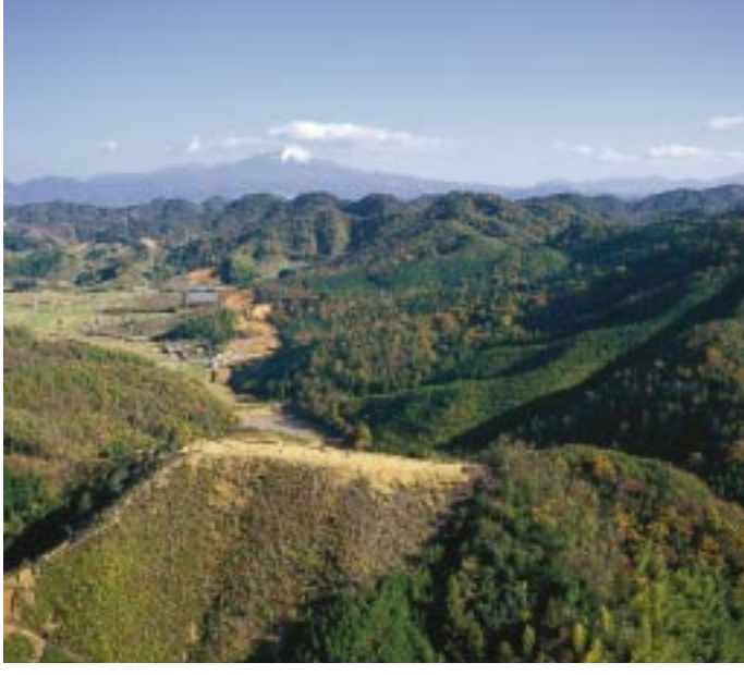
島根県ではじめて発見された高地性集落（陽徳遺跡：安来市門生町） 高地性集落とは、弥生時代中期から後期にかけて発生した高い丘や山の上にある集落のこと。生活には不便な場所にあることから、外敵の侵入を見張ったり、のろしをあげて連絡を取るために作られたと考えられる防御性の強い集落（詳しくは7巻を参照）。
