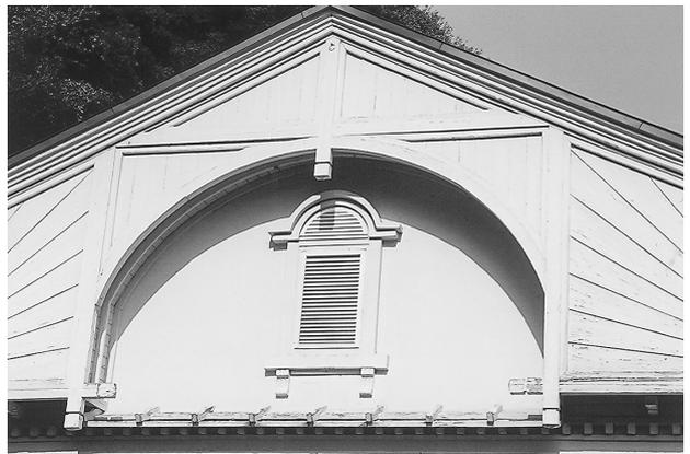
中国電力(株)窪田発電所全景と窓アーチ構造
