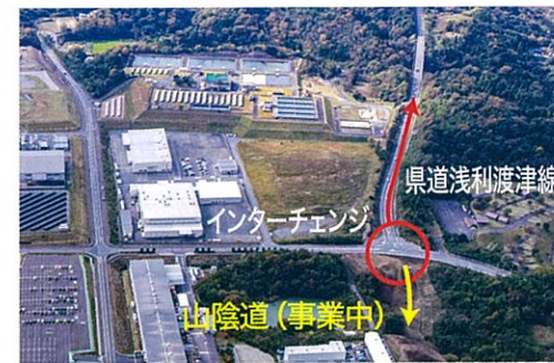
進む道路整備、利便性の向上
