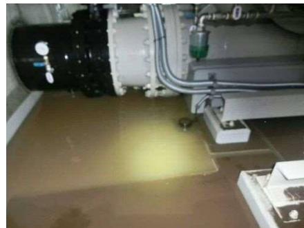
田井発電所の建屋内部
