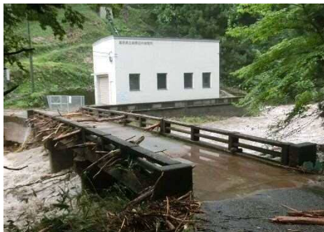
深野川と田井発電所
