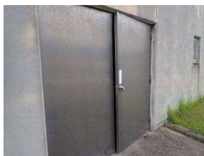
送水ポンプ室扉
