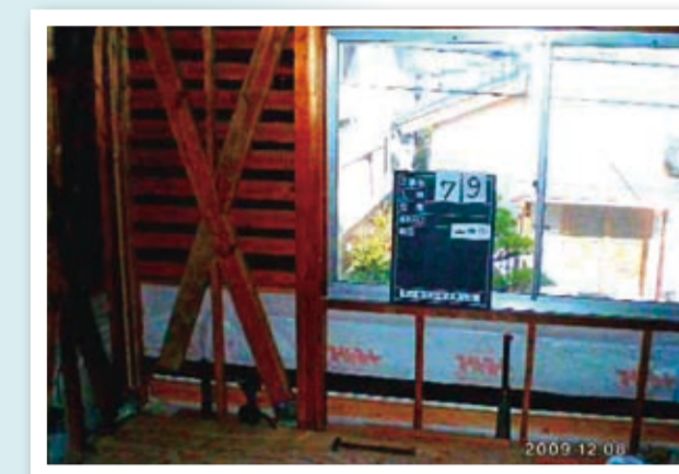
工事中筋交い
