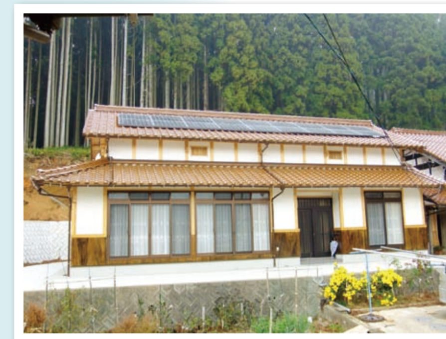
太陽光発電システム
