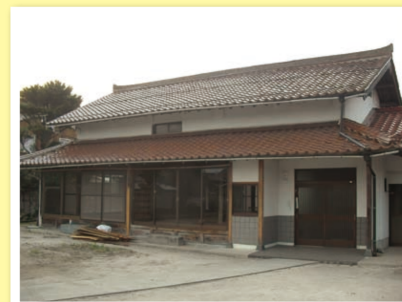
解体直前の母屋
