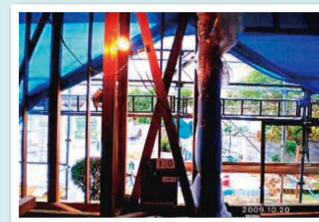
工事中筋交い
