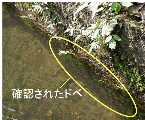
「4 宮部水路」で確認されたドベ(平成24年7月17日)
