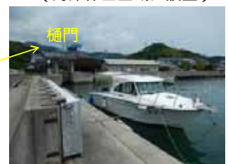
【西郷港海岸の樋門】 (海岸保全区域に設置)
