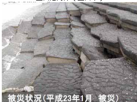
写真 高波による越波被害の事例
