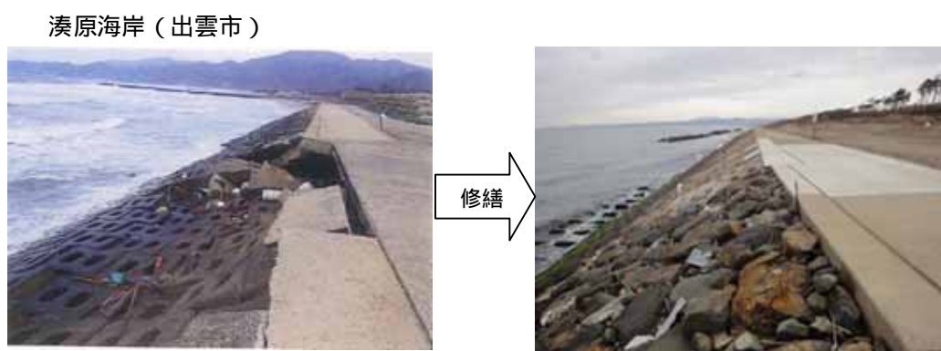
写真 海岸保全施設の老朽化と対策の事例
