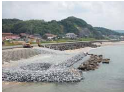
写真 海岸整備事業の事例（事業中）
