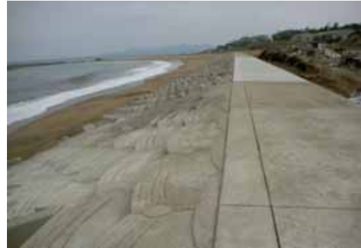
【侵食対策】小浜海岸（益田市）
