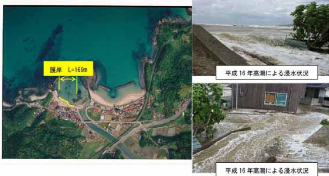
写真 高潮による浸水被害の事例
