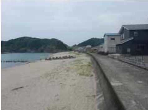
【侵食対策】浜田港日脚海岸（浜田市）
