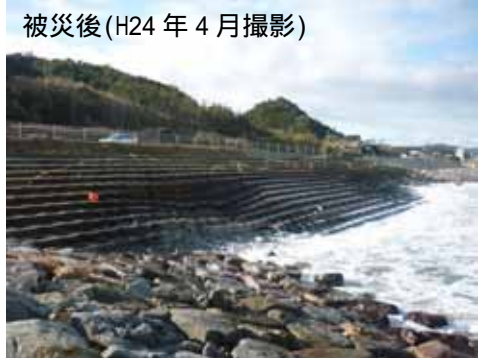
写真 近年の施設被害の事例
