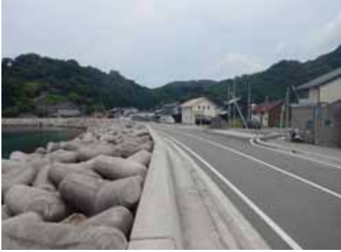
【高潮対策】浜田漁港海岸（浜田市）
