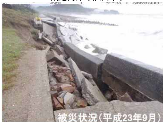
写真 高波による越波被害の事例
