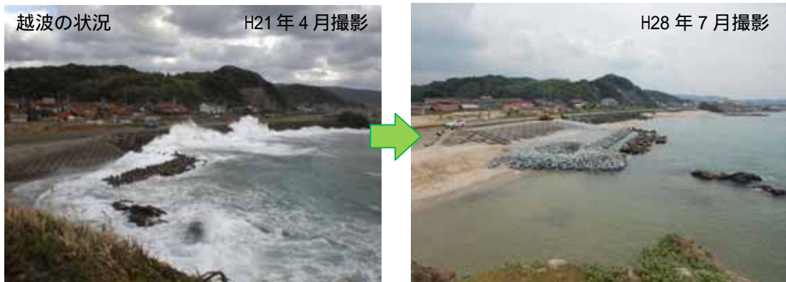
写真 越波と対策事例：和木波子海岸（江津市）
