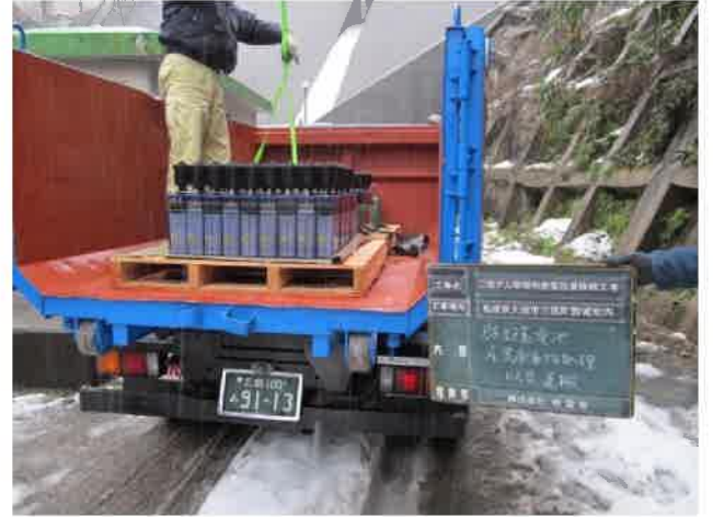
62 既設蓄電池収集運搬(3)
