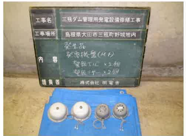
32 発電機盤発生品(2)
