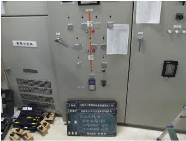
25 発電機盤交換中(1)
