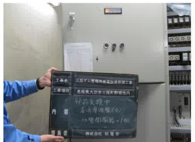
30 直流電源盤交換中
