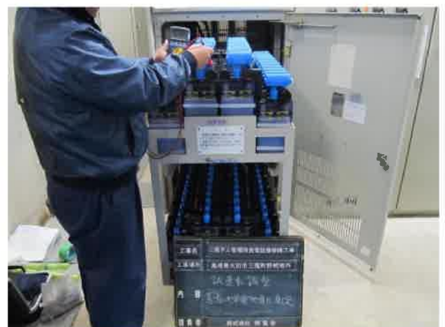
54 蓄電池試運転調整
