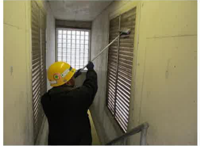
65 発電機室内清掃
