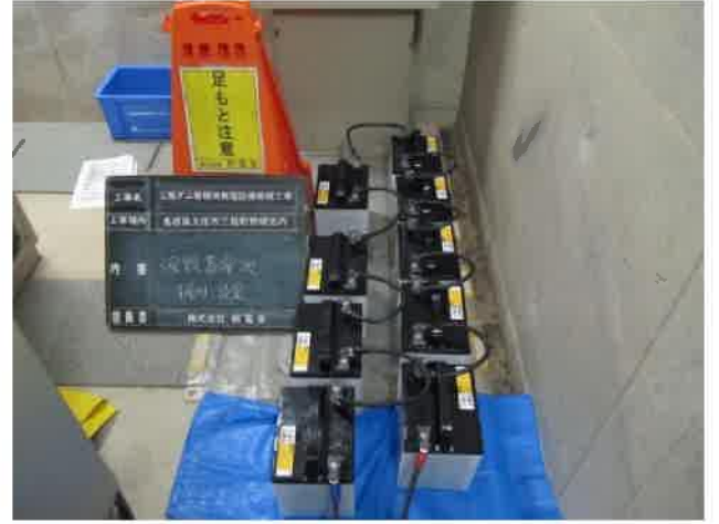
20 仮設蓄電池据付
