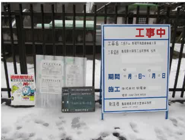
41 標識類の設置(1)
