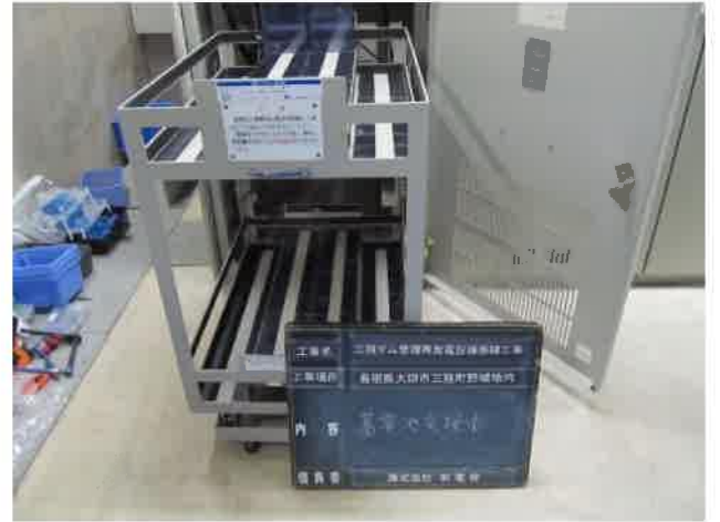
22 蓄電池交換中(2)
