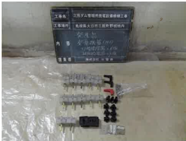
31 発電機盤発生品(1)
