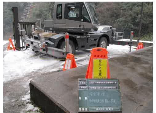
42 標識類の設置(2)
