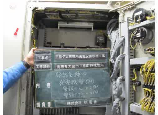
26 発電機盤交換中(2)
