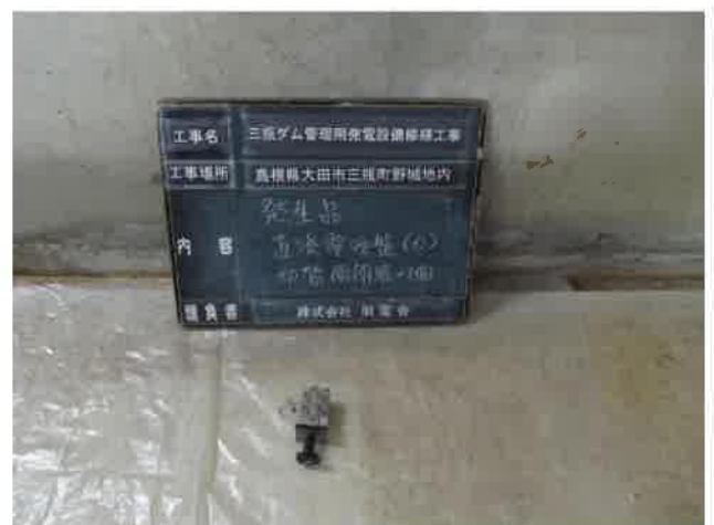
36 直流電源盤発生品
