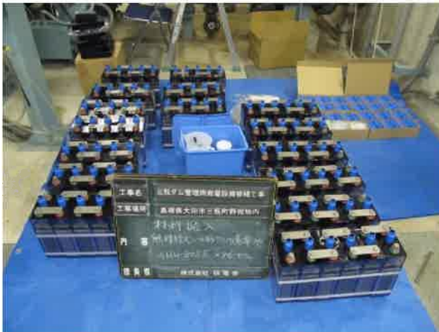
45 材料搬入蓄電池
