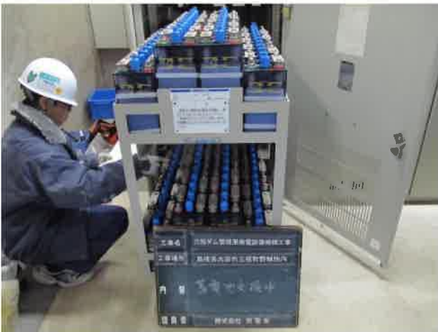
23 蓄電池交換中(3)
