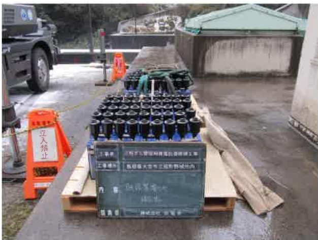
59 既設蓄電池撤去
