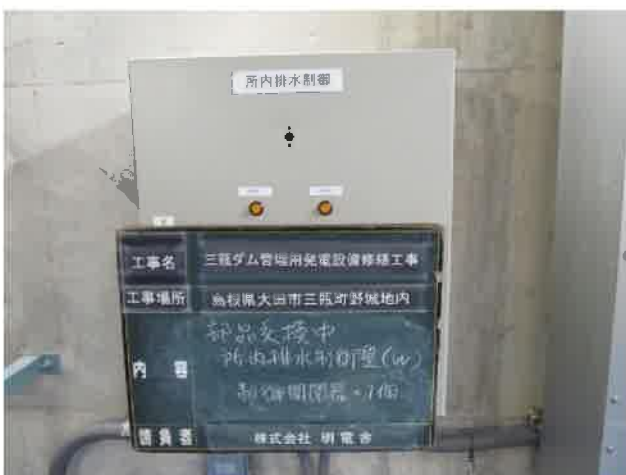
29 所内排水制御盤交換中
