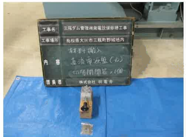
52 材料搬入直流電源盤
