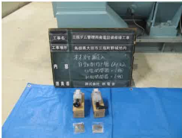
49 材料搬入自動制御盤
