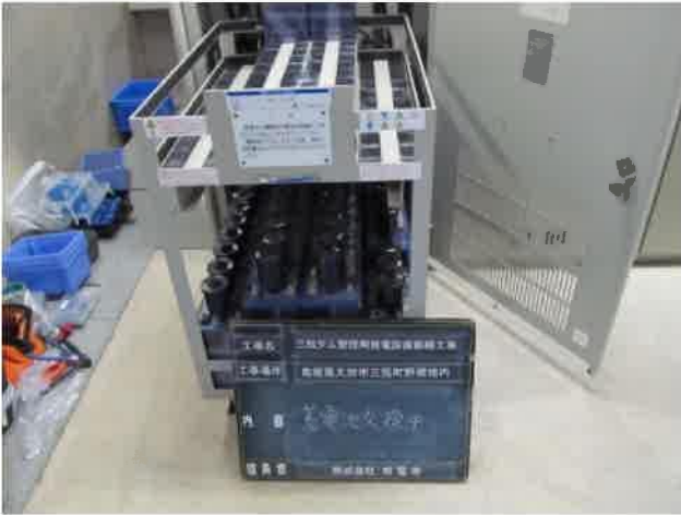
21 蓄電池交換中(1)
