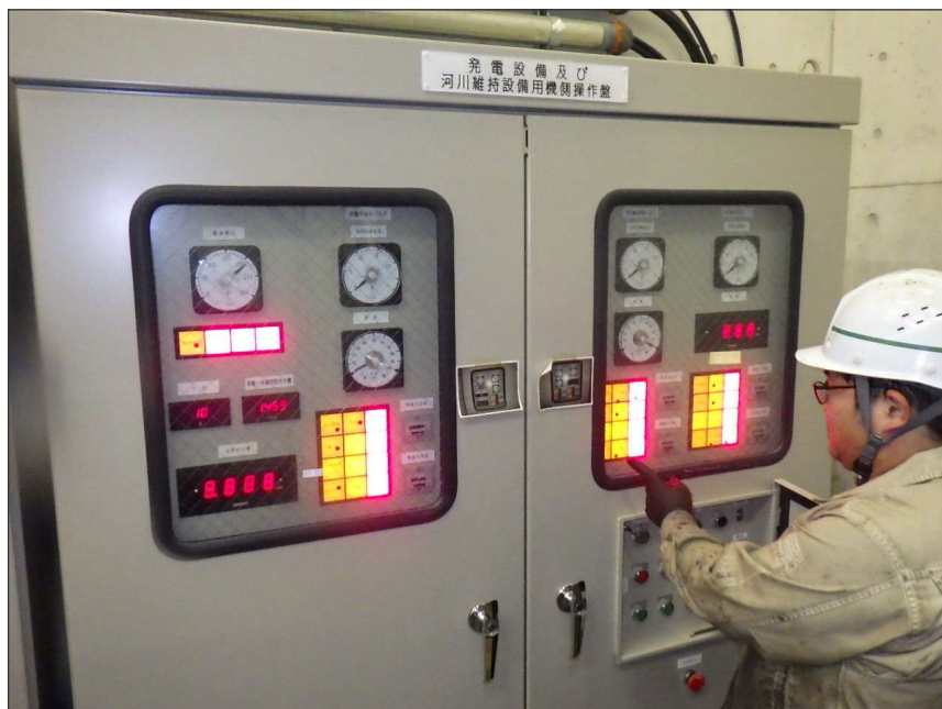
写真区分: 施工状況写真 工種: (共通) 発電・河川維持 用設備 種別: 機側操作盤 写真タイトル: ランプテスト 確認状況 撮影箇所: 機側操作盤
