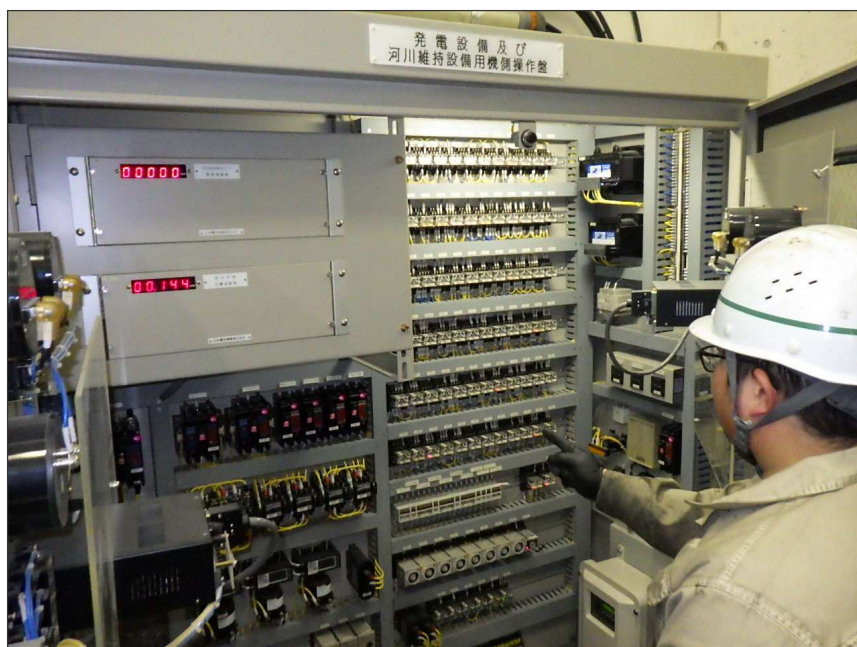
写真区分: 施工状況写真 工種: (共通) 発電・河川維持 用設備 種別: 機側操作盤 写真タイトル: 外観点検状況 撮影箇所: 機側操作盤
