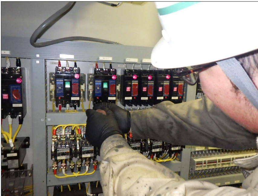
写真区分: 施工状況写真 工種: (共通) 発電・河川維持 用設備 種別: 機側操作盤 写真タイトル: 端子緩み点検 状況 撮影箇所: 機側操作盤
