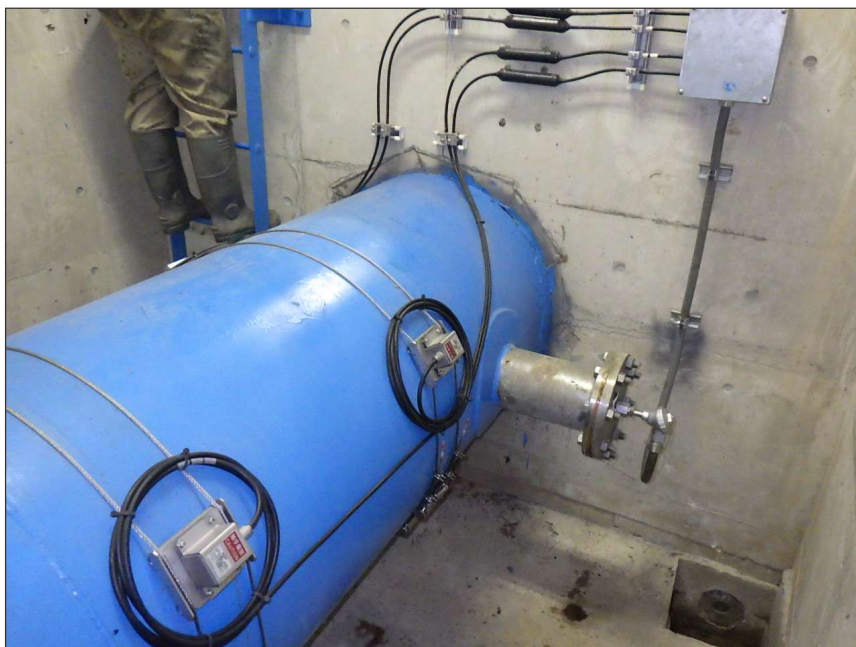
写真区分: 施工状況写真 工種: (共通) 発電・河川維持 用設備 種別: 取水管路 写真タイトル: 外観点検状況 撮影箇所: 流量計
