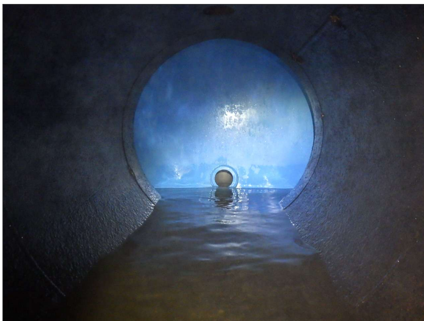
写真区分: 施工状況写真 工種: (共通) 発電・河川維持 用設備 種別: 取水管路 写真タイトル: 水密確認状況 撮影箇所: 制水ゲート
