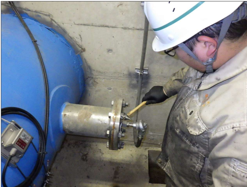
写真区分: 施工状況写真 工種: (共通) 発電・河川維持 用設備 種別: 取水管路 写真タイトル: ボルト緩み点 検状況 撮影箇所: 流量計
