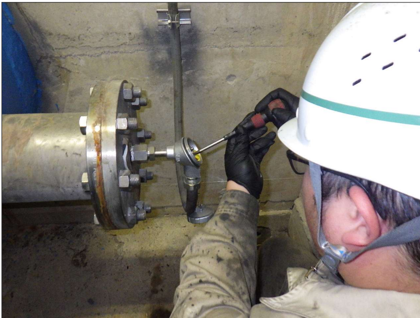
写真区分: 施工状況写真 工種: (共通) 発電・河川維持 用設備 種別: 取水管路 写真タイトル: 端子緩み点検 状況 撮影箇所: 流量計
