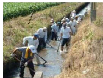
農業用水路の泥上げ
