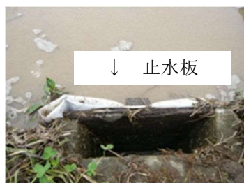
止水板の設置
