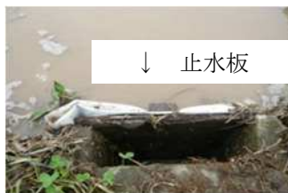
止水板の設置
