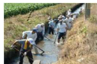
農業用水路の泥上げ
