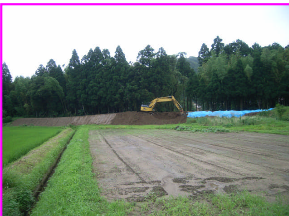
・知谷工区その1 破堤箇所復旧状況
