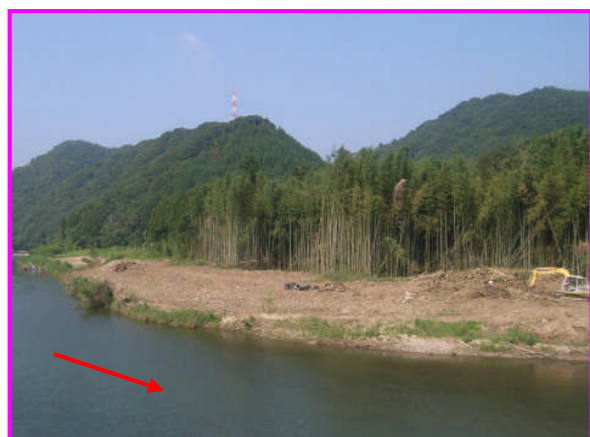
・知谷工区その1 工事準備(伐開)状況
