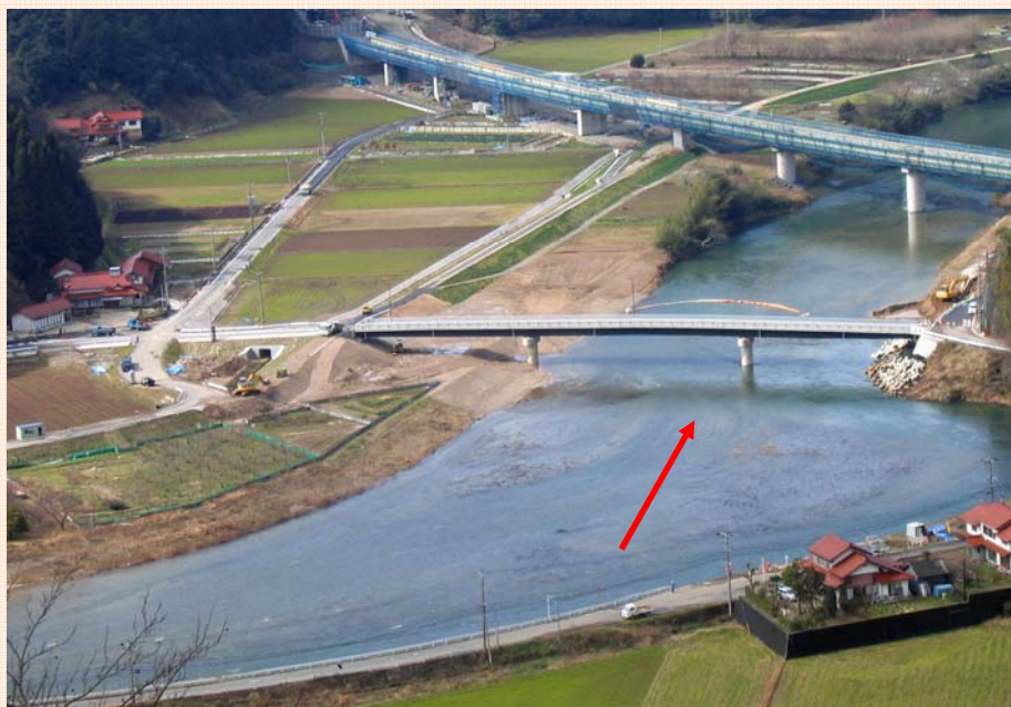
知谷工区(その3)全景
