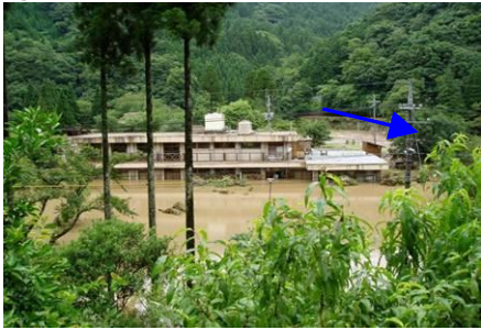
② 被災した吊橋(酔潺橋)
