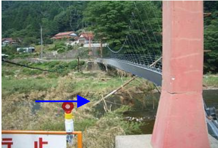
③ 一面が浸水地帯となる
