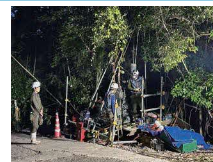
地質調査の状況
