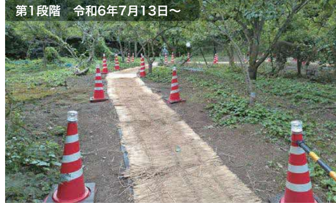
第1段階 令和6年7月13日～ 歩行者用通路を整備
