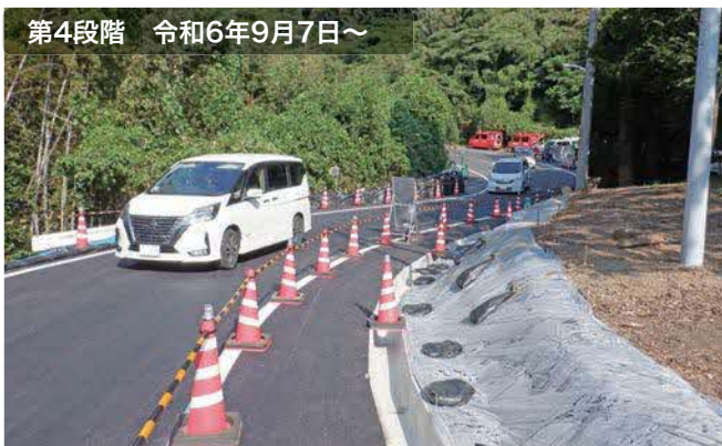
第4段階 令和6年9月7日～ 大型車を除く一般車両の仮設道路を整備(片側交互通行)
