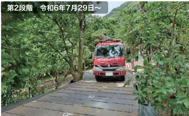
第2段階 令和6年7月29日～ 緊急車両等に限定した仮設道路を整備
