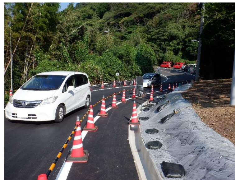
仮設迂回道路状況写真(令和6年9月7日 撮影)
