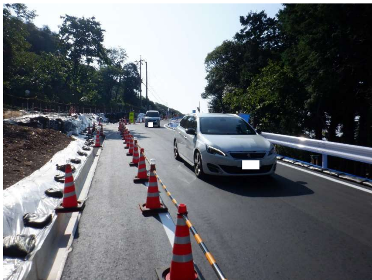
仮設迂回道路状況写真(令和6年9月7日 撮影)
