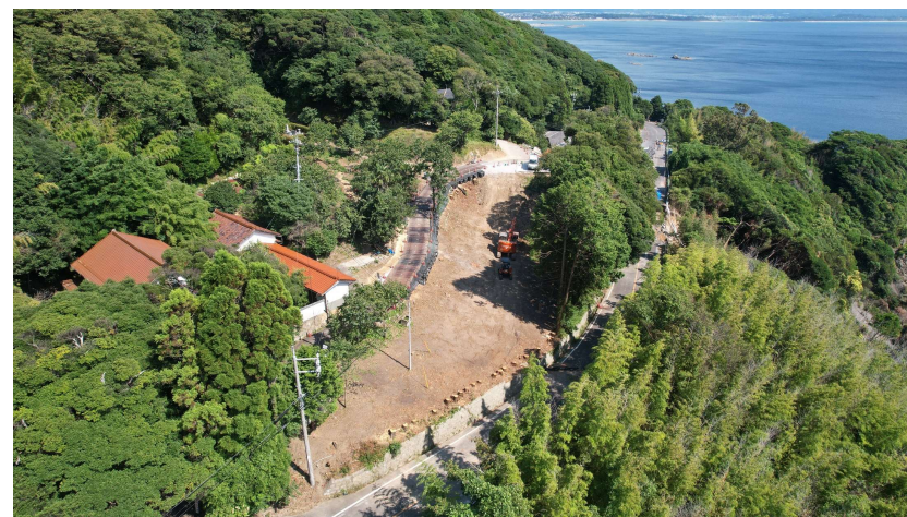
仮設迂回道路状況写真(令和6年8月14日 撮影)
