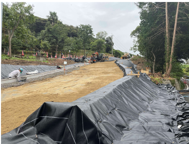
仮設迂回道路状況写真(令和6年8月29日 撮影)
