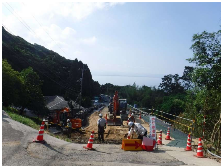
坂路設置作業状況写真(令和6年8月5日 撮影)
