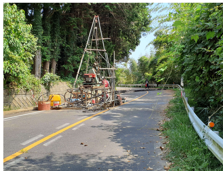
土質調査状況写真(令和6年8月3日 撮影)
