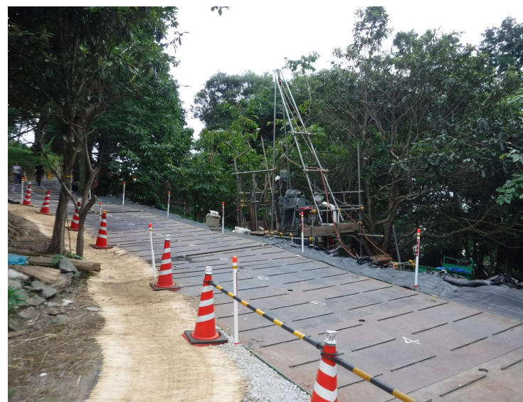
土質調査状況写真(令和6年8月3日 撮影)
