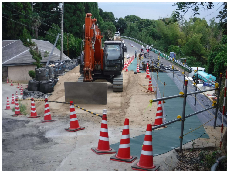
坂路設置作業状況写真(令和6年8月3日 撮影)
