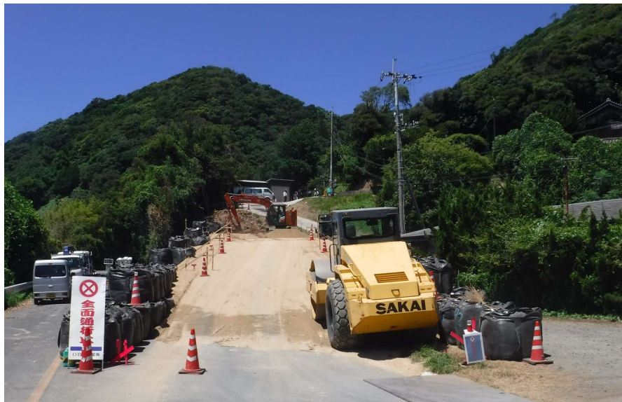
坂路設置作業状況写真(令和6年8月1日 撮影)
