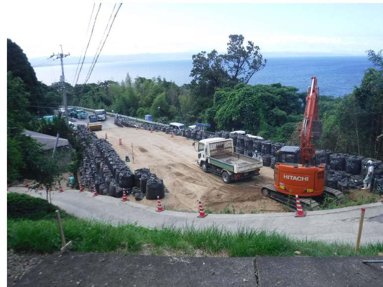
坂路設置作業状況写真(令和6年8月1日 撮影)
