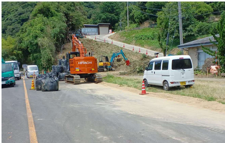
坂路設置作業状況写真(令和6年7月27日 撮影)
