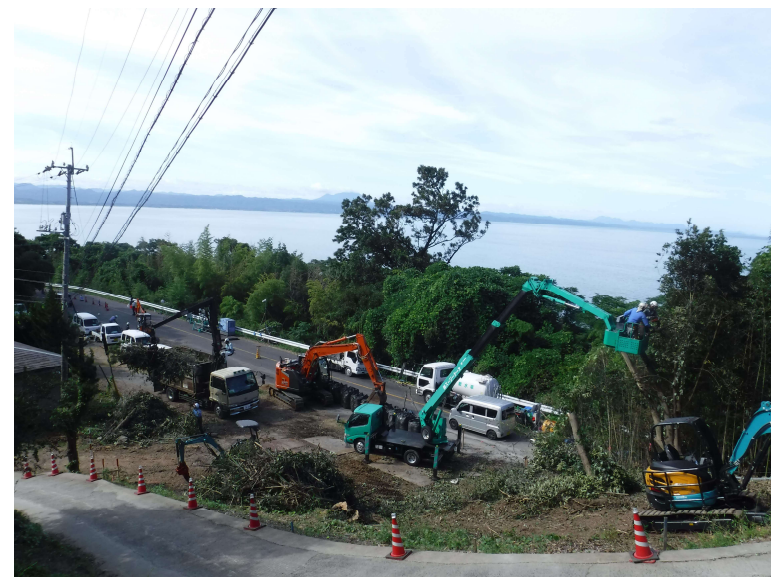
坂路設置作業状況写真(令和6年7月27日 撮影)
