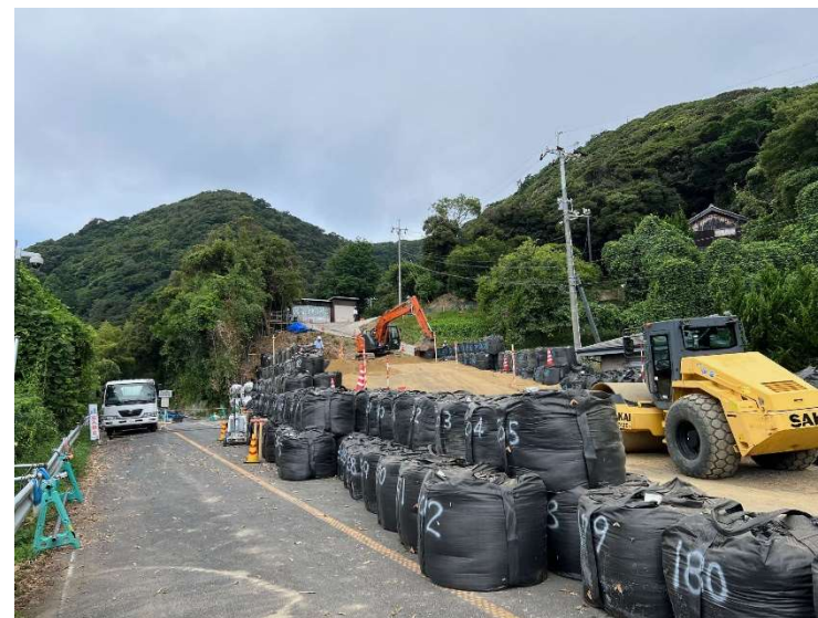
坂路設置作業状況写真(令和6年7月31日 撮影)
