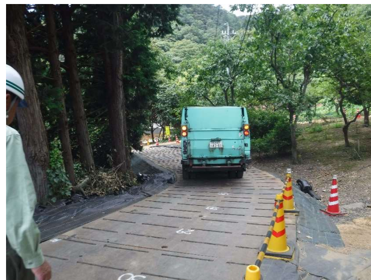
緊急車両限定仮設迂回路状況写真(令和6年7月29日 撮影)
