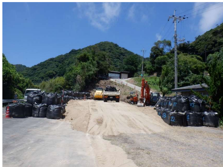
坂路設置作業状況写真(令和6年7月29日 撮影)
