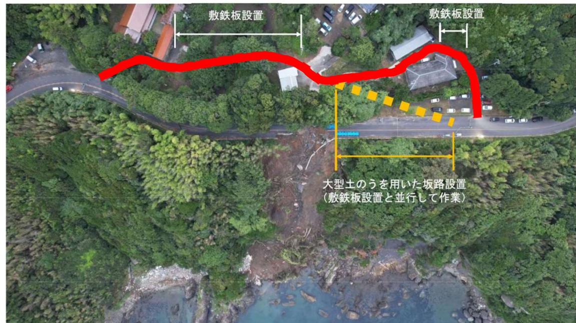
図. 緊急車両等に限定して通行が可能となる措置
