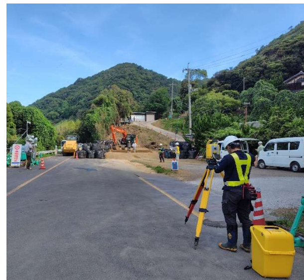
坂路設置作業状況写真(令和6年7月29日 撮影)
