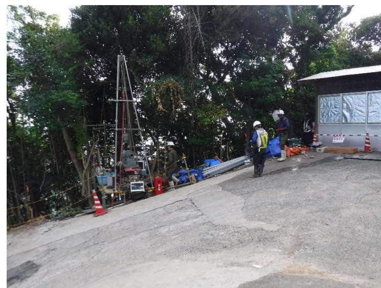
土質調査状況写真(令和6年7月29日 撮影)
