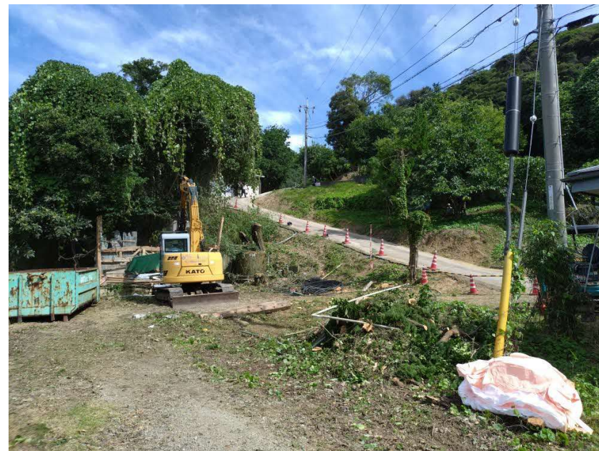
坂路設置作業状況写真(令和6年7月25日 撮影)
