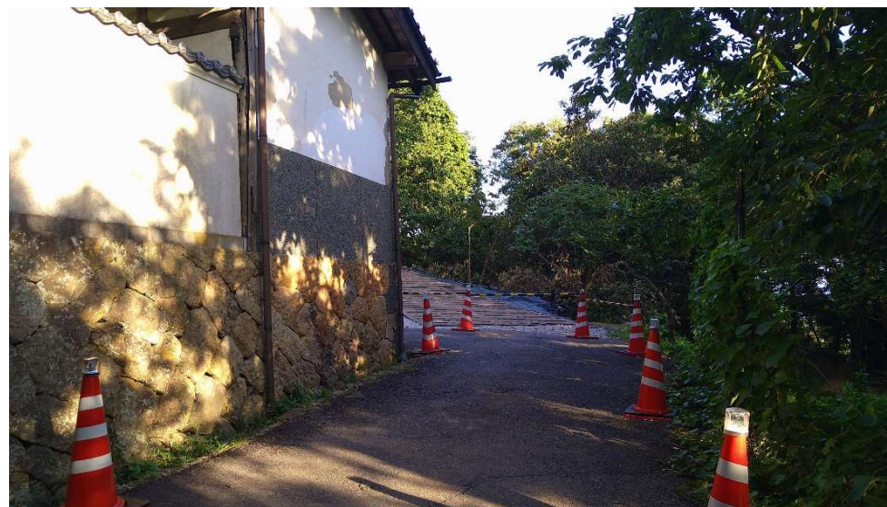
緊急車両限定仮設迂回路状況写真(令和6年7月28日 撮影)
