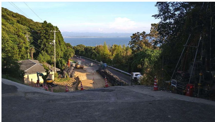
坂路設置作業状況写真(令和6年7月28日 撮影)
