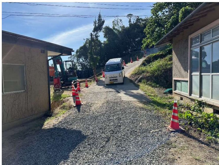
緊急車両限定仮設迂回路状況写真(令和6年7月28日 撮影)
