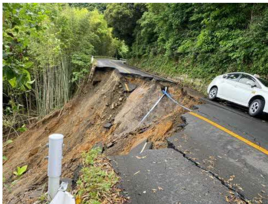
被災状況写真(R6.7.10 9:00ごろ撮影)
