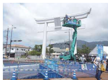
クレーン車からの現場見学
